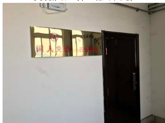
锅炉烟气在线监测站房
