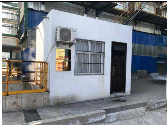
焚烧炉烟气在线监测站房
