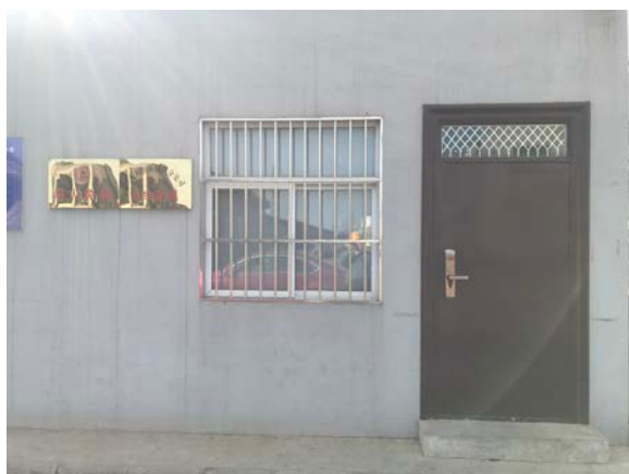
废水在线监测室
