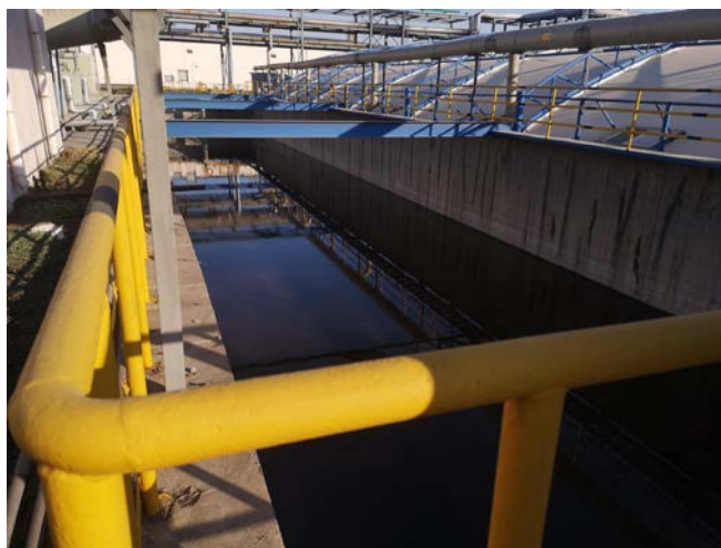
初期雨水收集池
